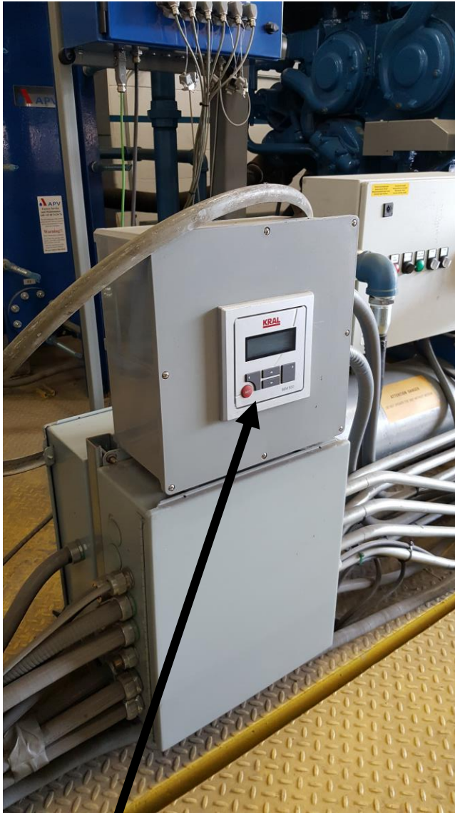
#9 Kral Flow Meter Controller (BEM 500)
